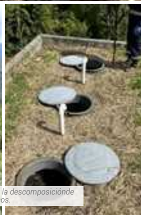
Fotografía 20. Trampa de grasas: Remueve aceites y grasas del agua residual
